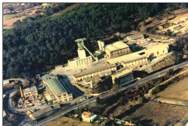
Fig. 10. Vue aérienne du carreau du puits Gérard, vers 1990. Cl. CdF R. Monteau.
