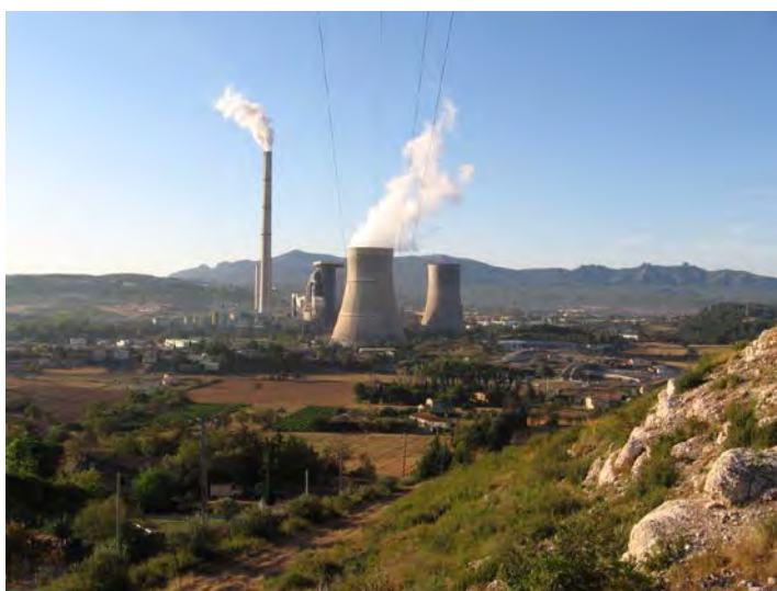
Centrale thermique vue du nord. Arrière-plan : chaîne de l'Etoile.
